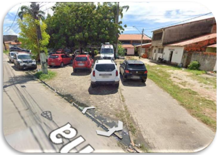
Figura 5 - Vista frontal da EEMTI João Nogueira Jucá com presença de unidade móvel de segurança
