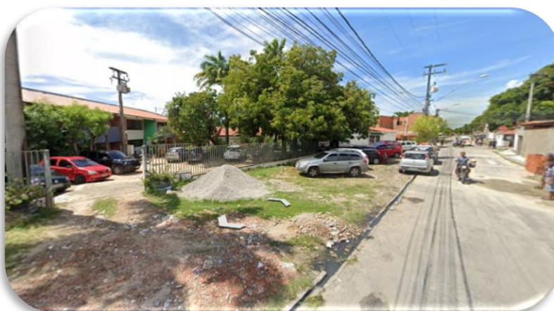
Figura 4 - Vista lateral das instalações da EEMTI João Nogueira Jucá
